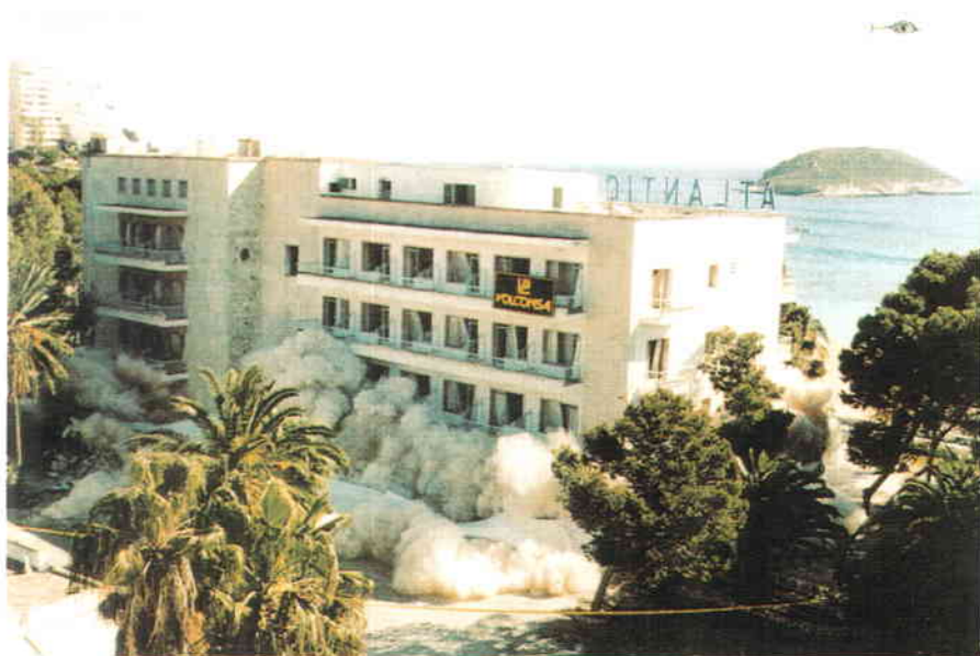
Por lo sano: la demolición de hoteles permite crear espacios abiertos. Voladura del Hotel Atlántic de Calviá. Febrero, 1996.
